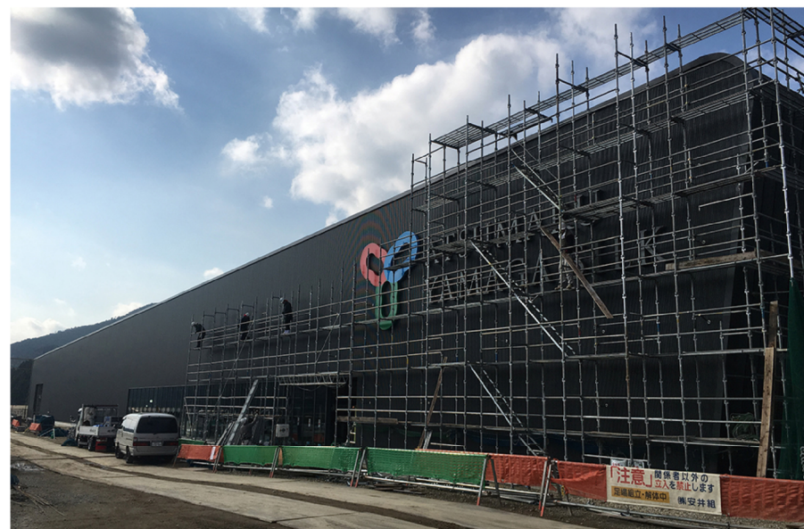
1月11日の足場撤去の様子
