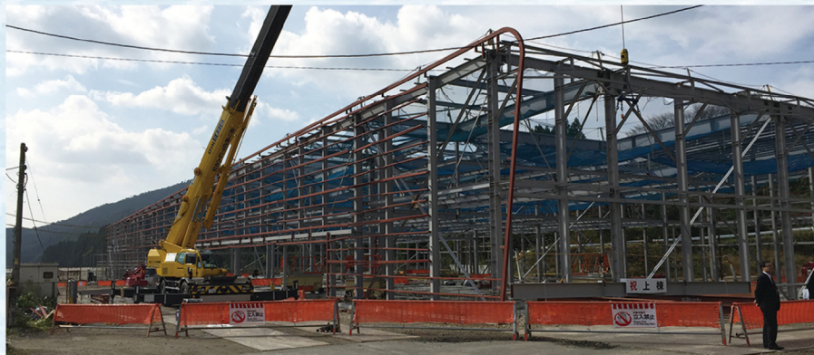
建設中の無菌養蚕プラント
